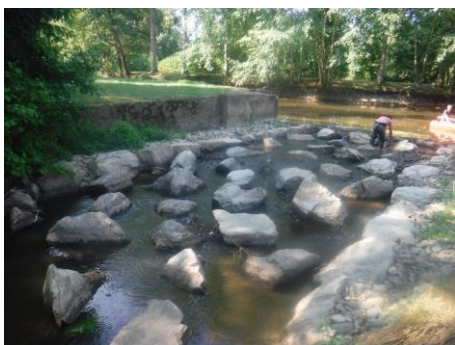
Vue amont ouvrage A, 2018
