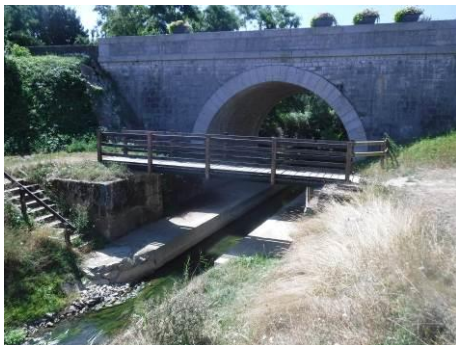
Passerelle aménagée au pont routier 2018
