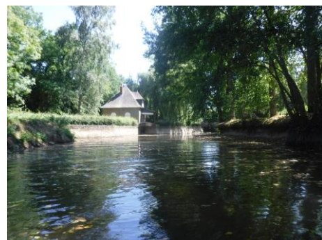
Vue amont ouvrage B, 2018
