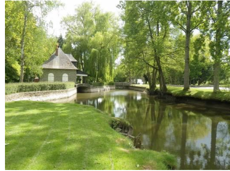
Vue amont ouvrage B, 2017
