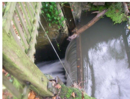
Vue sur le vannage
