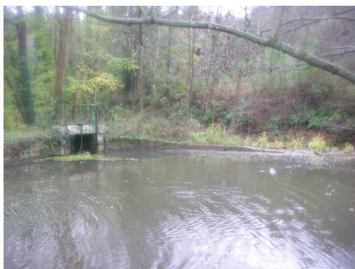
Vue sur le déversoir accolé au vannage
