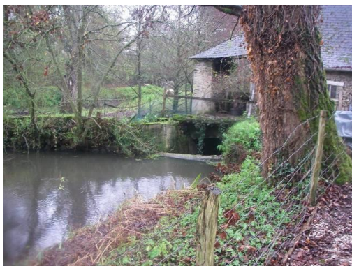
Vue sur le vannage usinier
