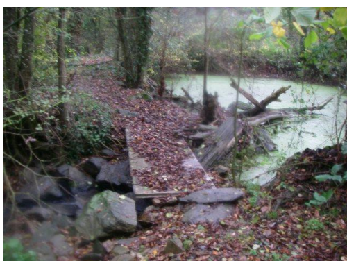
Vue sur l'entrée du déversoir
