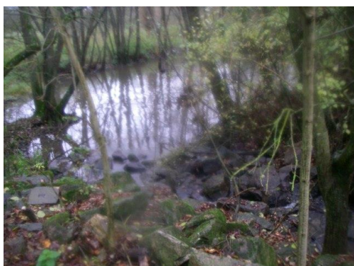
Vue générale sur l'aval du déversoir
