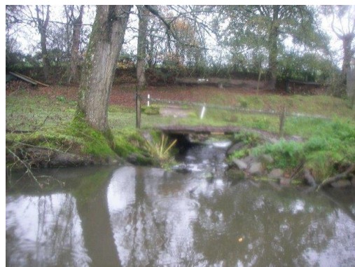
Vue sur le déversoir
