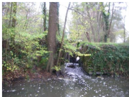
Vue sur le vannage de décharge
