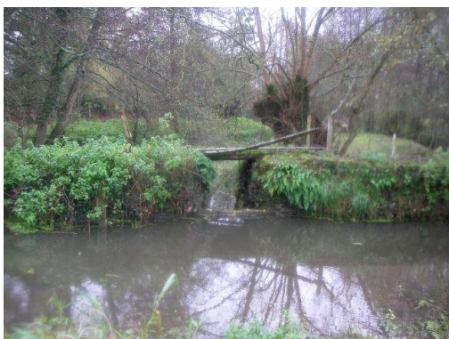
Vue sur le deuxième déversoir
